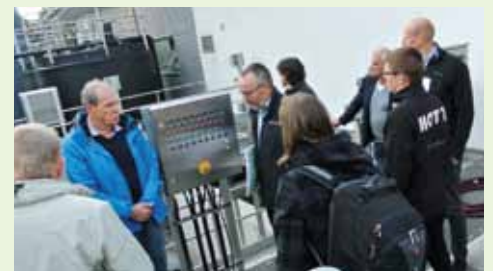
Gelungener Abschluss des Technologieforums: die Besichtigung der Tuchfilter-Anlage beim AZV Raumschaft Lahr
