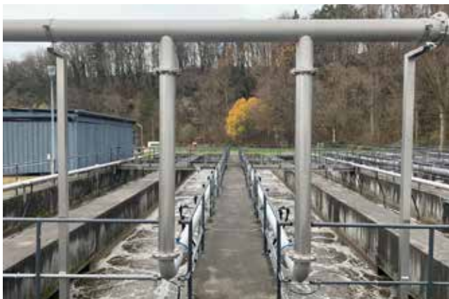
Abb. 3: Belebungs 1 mit Luftverteilung
