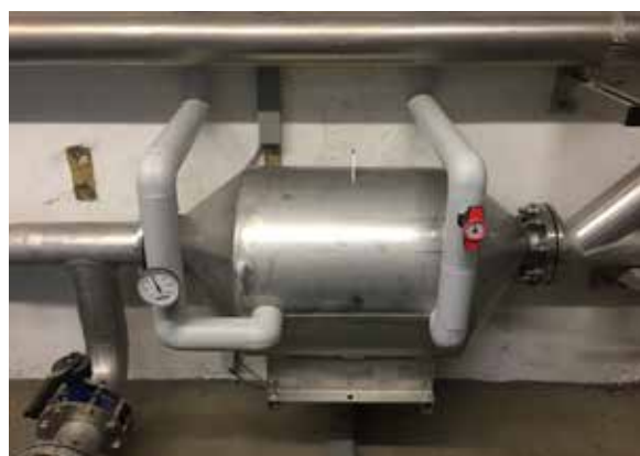
Abb. 3: Wärmerückgewinnung aus der Abluft der Gebläse
