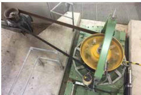
Abb. 3: Flusskraftwerk mit doppelt geregelter Kaplanturbine ( H = 5,10 \text{ m} , P_{\text{max}} = 87 \text{ kW} )
