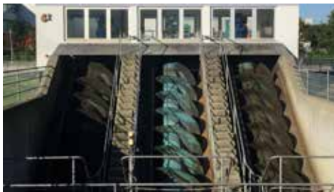
Abb. 2: Zwischenhebewerk zur Förderung von Ablauf Vorklärung und Rücklaufschlamm
