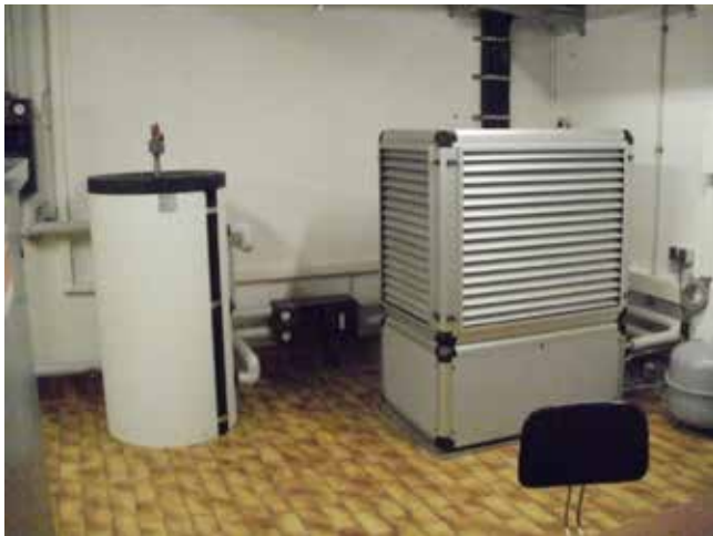
Abbildung 1: Wärmepumpe zur Beheizung des Betriebsgebäudes und Warmwasserbereitung (Nutzung der Gebläseabwärme im Gebläseraum) auf der Kläranlage Böhringen
