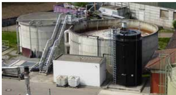
Abb. 3: SBR-Biologie zur Prozesswasserbehandlung
