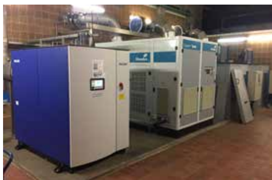
Abb. 2: Verdichterstation mit Schwachlastverdichter, Teststellung und zwei Vollastverdichtern incl. Redundanz
