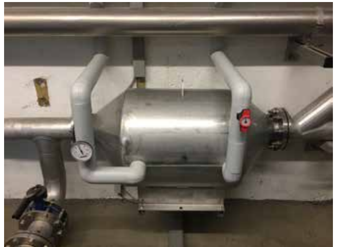
Abbildung 2: Wärmerückgewinnung aus der Abluft der Gebläse auf der Kläranlage Schömburg
