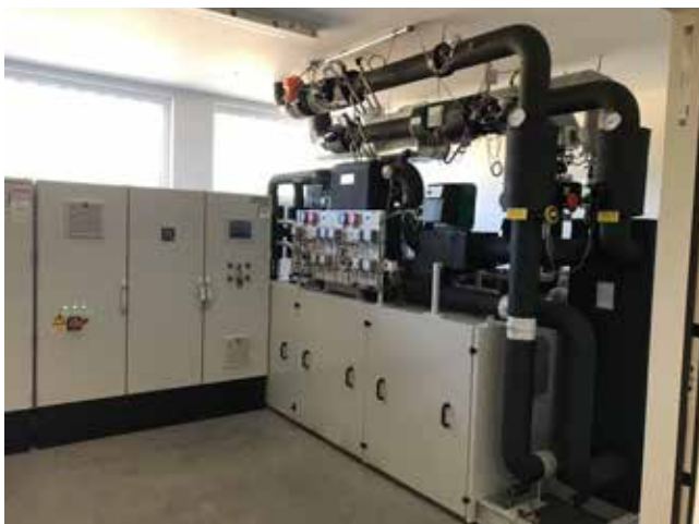
Abb. 3: Wärmepumpe (Fabrikat Combitherm)
