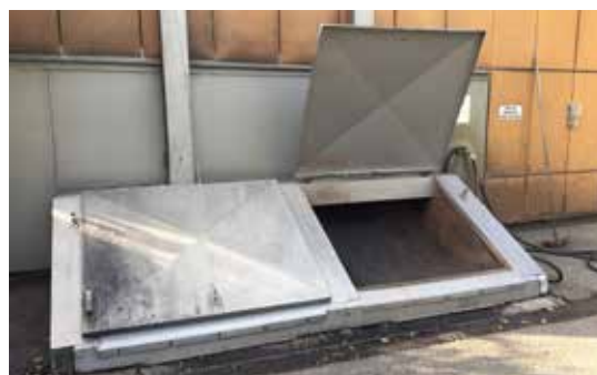
Abb. 2: Annahmeschacht der Brennschlempe
