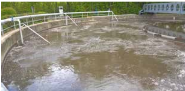
Abb. 2: Kombibecken mit innenliegender vorgeschalteter Denitrifikation und außenliegender Nitrifikation
