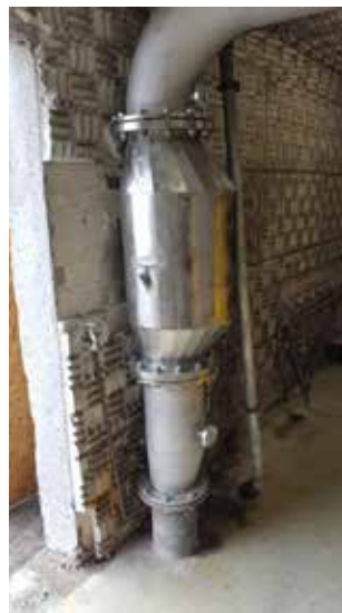
Abbildung 1: Wärmepumpe zur Beheizung des Betriebsgebäudes und Warmwasserbereitung (Nutzung der Gebläseabwärme im Gebläseraum) auf der Kläranlage Böhringen
