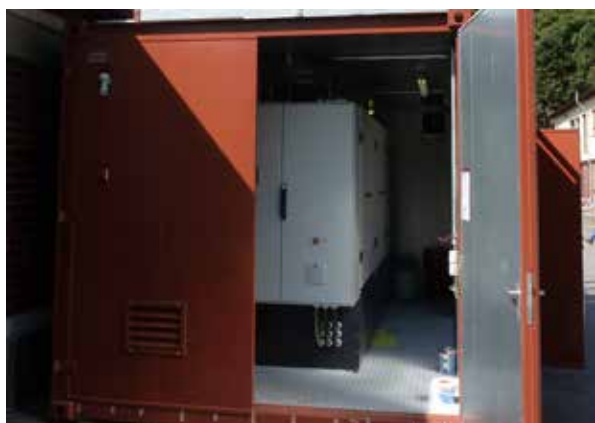
Abb. 2: YADOS-BHKW in einem Container
