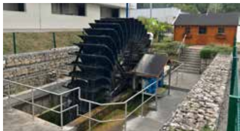
Abb. 3: Wasserrad im Ablauf
