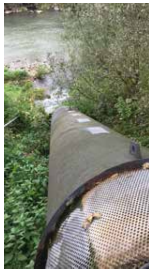
Abbildung 4: Wasserkraftnutzung mit einer Wasserkraftschnecke auf der Kläranlage Rottenburg ( D = 1.000\text{ mm} , Q = 260\text{ l/s} , H = 3,40\text{ m} , P_{el} ca. 6,7\text{ kW} )
