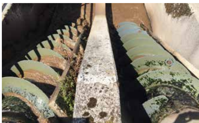
Abb. 3: Rücklaufschlammförderung mit energieeffizienten Motoren
