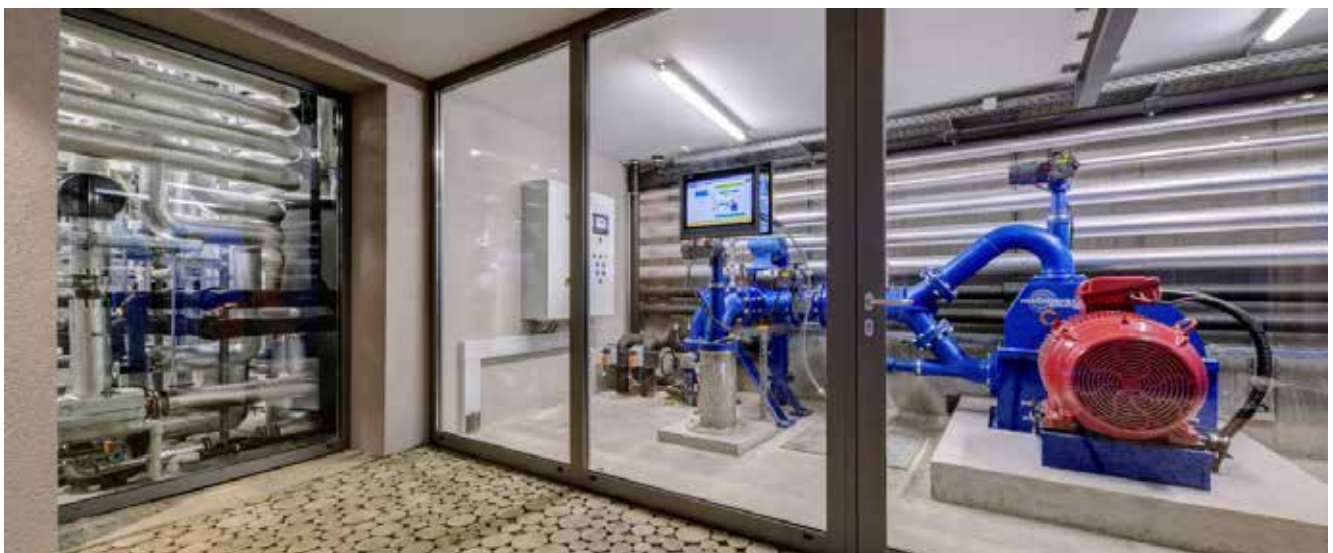
Abb. 2: Pelton-Turbine (rechts) und ein Teil der Energiezentrale (links)
