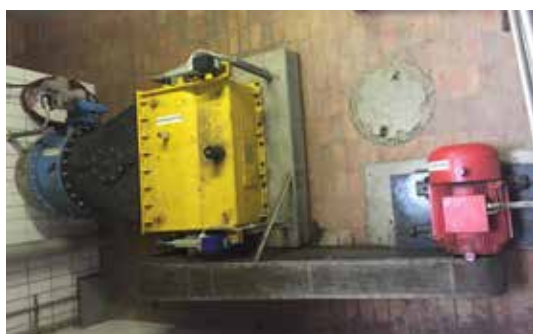
Abb. 3: Abwasserturbine im Kläranlagenablauf in die Fils
