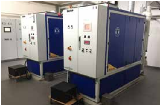
Abb. 2: BHKW zur Verstromung des Faulgases
