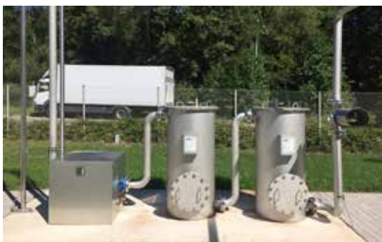
Abb. 3: Abluftreinigung des Vorlagebehälters mit Aktivkohle
