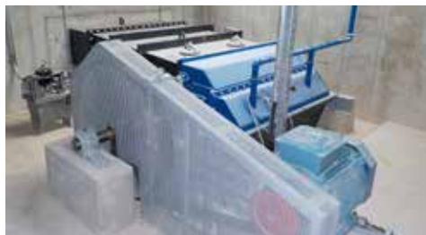
Abb. 3: Wasserkraftanlage im Ablauf der 4. Reinigungsstufe
