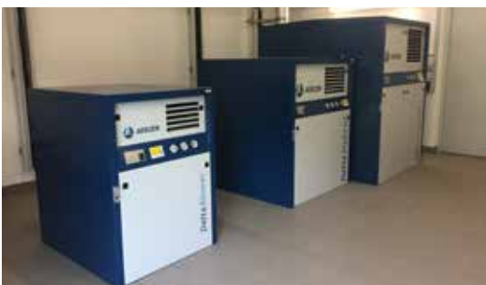
Abb. 3: Neue Verdichterstation mit abgestuften Gebläsen
