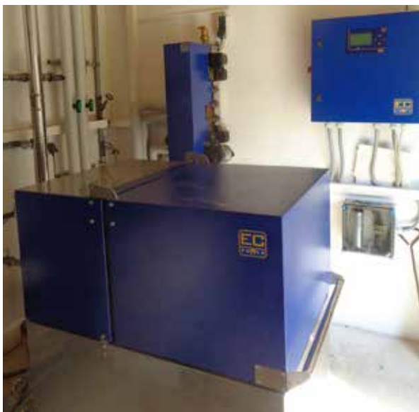
Abb. 2: BHKW mit 15 kW el
