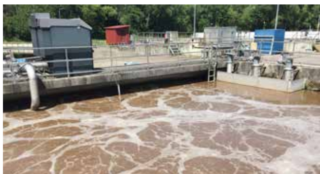
Abb. 2: Einzelstehende Gebläse am Beckenrand und Pumpwerk der Internen Rezirkulation mit Propellerpumpen
