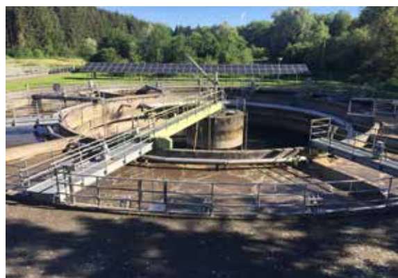
Abb. 2: Belebungsbecken (Außenring) mit Schlamm-puffer (Innenring)
