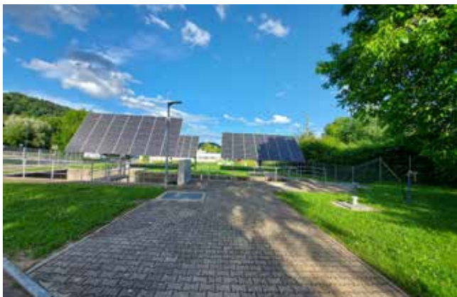
Abbildung 5: PV-Anlage mit drei vollautomatischen 2-achsigen Nachführsystemen (Deger-traker) auf dem RÜB 28 auf dem Klärwerk in Murrhardt mit 32,76\text{ kWp}
