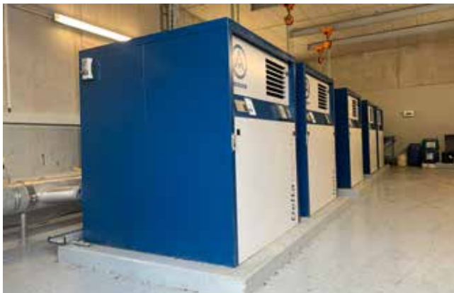
Abb. 2: Gebläsestation für die BB 3
