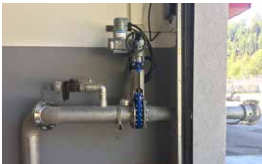
Abb. 2: Annahmestelle für das Flotat aus der Fleischverarbeitung
