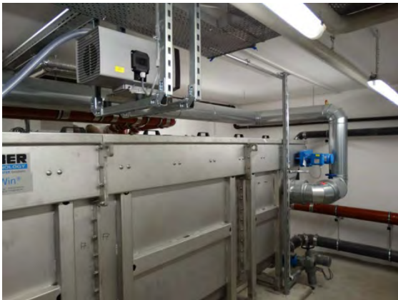
Abbildung 20: Externer Wärmetauscher im Behälter. Quelle: IBS.
