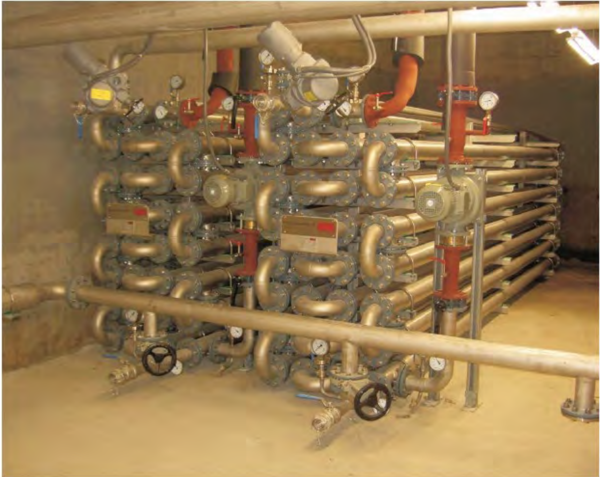
Abbildung 4: Außerhalb des Kanals angeordneter Wärmeübertrager (geschlossenes System) zur Rückgewinnung von Wärme aus dem Abwasser. Foto: Kobel, B.; Ryser Ingenieure AG, Bern, entnommen aus (DWA-Merkblatt M114, 2020).
