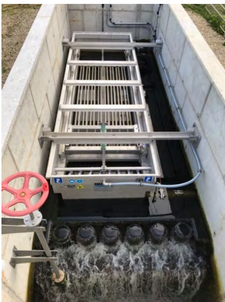
Abbildung 19: Wärmetauscher im Gerinne zum Vorfluter. Quelle: Huber.
