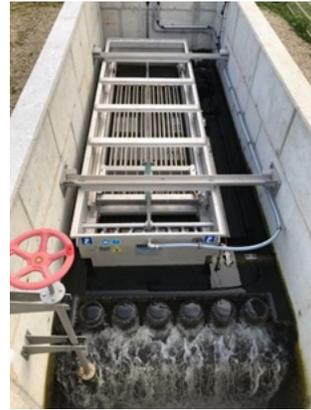
*Wärmepumpe im Kläranlagenauslauf, Foto: Huber*
