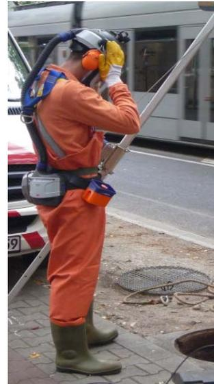
Beispiele: Partikelfiltrierende Halbmaske / Vollmaske / Schutzbelüftung (Quelle: BWB, SEBD)
