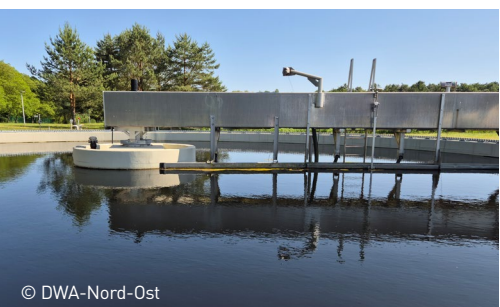
Kläranlage Schönermark, Brandenburg
