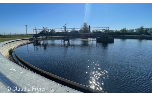
Kläranlage Kläranlage Seelow, Brandenburg
