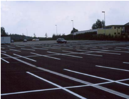
Bild 3-2: Wasserundurchlässige Befestigung bei Großparkplätzen
