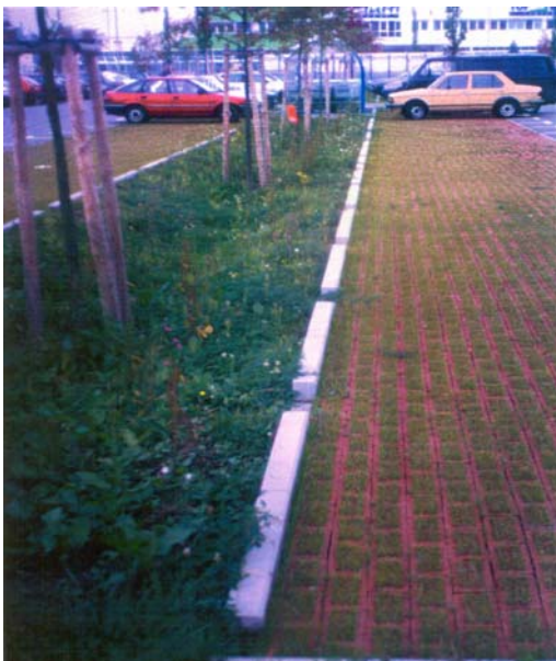
Bild 3-4: Durchlässige Befestigungen kombiniert mit bewachsenen Versickerungsmulden
