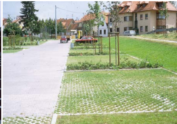
Bild 3-3: Durchlässige Befestigungen mit Rasengittersteinen
