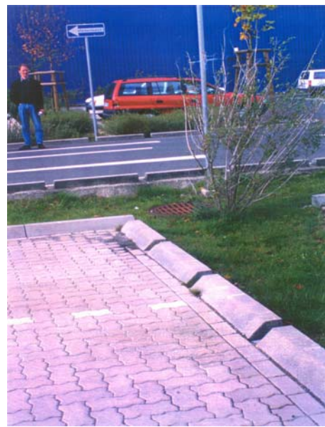
Bild 3-5: Definierte Versickerung über Rasenmulden bei wasserundurchlässiger Befestigung
