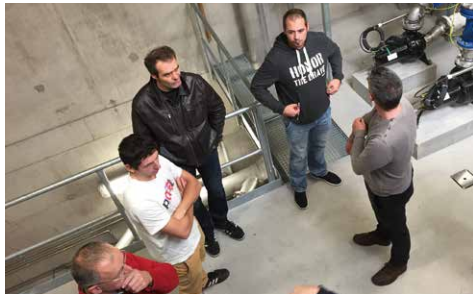
Besichtigung eines Regenüberlaufbeckens
